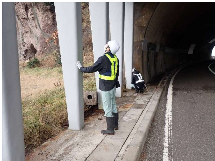
緊急点検(洞門)の様子 開発技建(株) 提供
