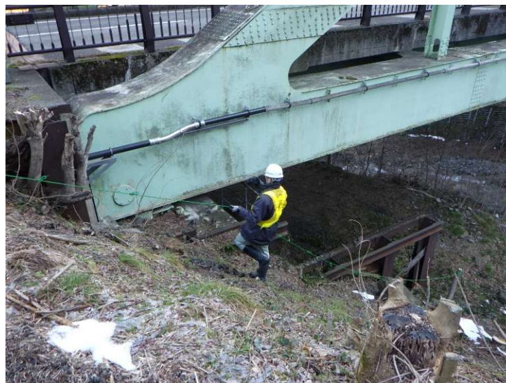
緊急点検(橋梁)の様子 (株)構造技研新潟 提供
