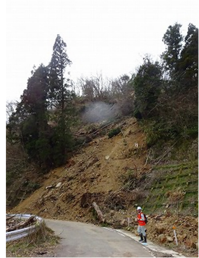
⑬-6_240410 北河内ダム.jpg
