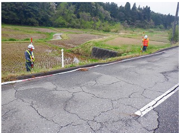
16_240424(2)_34号(主)能都穴水線.jpg
