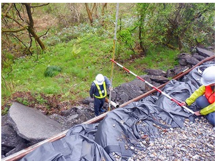
16_240424(4)_34号(主)能都穴水線.jpg
