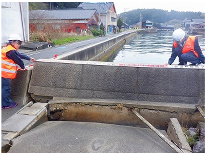
15_240424(3)_34号(主)能都穴水線.jpg
