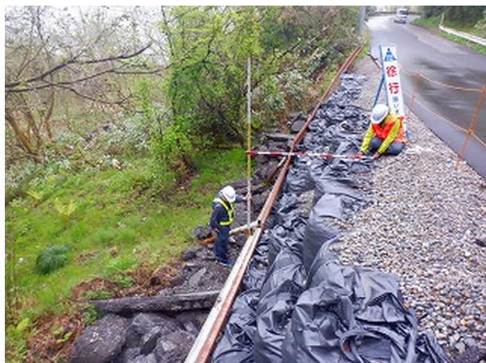
16_240424(3)_34号(主)能都穴水線.jpg
