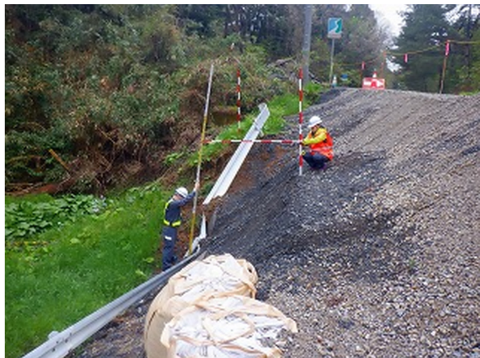
16_240424(1)_34号(主)能都穴水線.jpg
