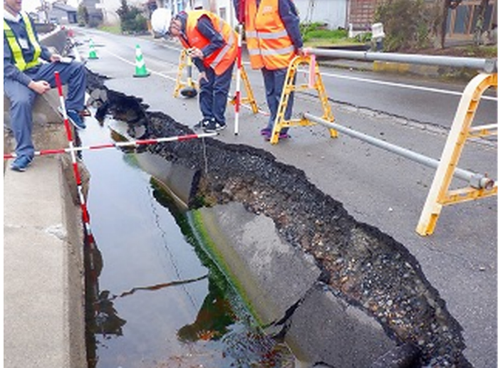
15_240424(1)_34号(主)能都穴水線.jpg
