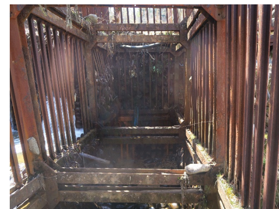
【本堤左岸側・左岸側壁(枠内)】
