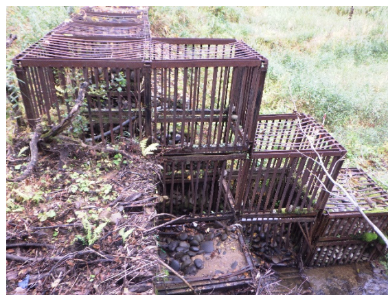
【本堤左岸側・左岸側壁】
