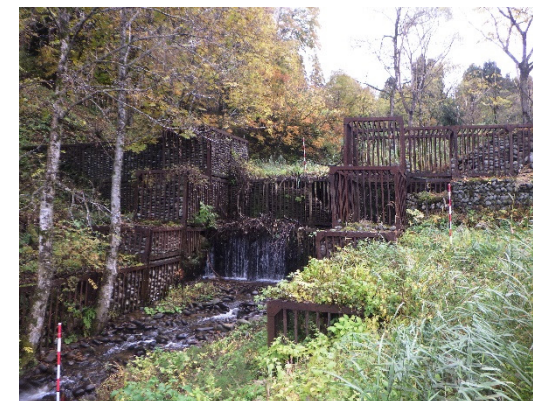
【対象施設全景】
