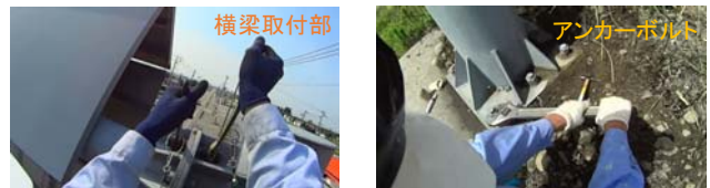
図-6 点検状況写真。
