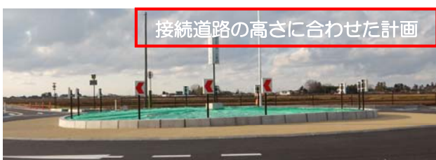
図-10 中央島・エプロン部の状況
