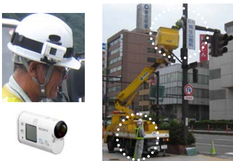
図-5 ヘルメットカメラ導入による点検状況。
