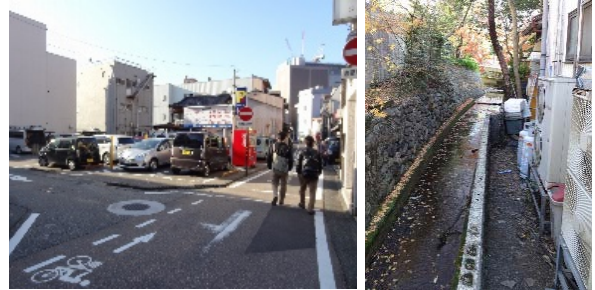
写真-1 柿木島ゾーンの現況
