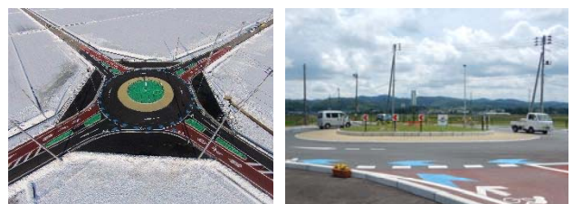
図-12 整備後の状況
