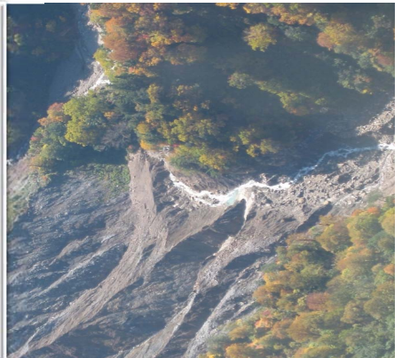
河川閉塞は確認できない
