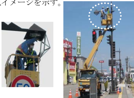
図-4 通常の点検状況。
