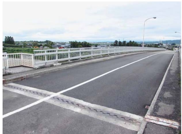
写真-2 補修工事後（橋面全景）
