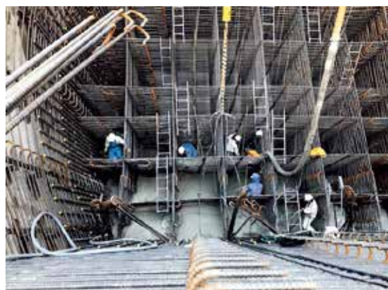
写真5 コンクリート打設（1リフト目）
