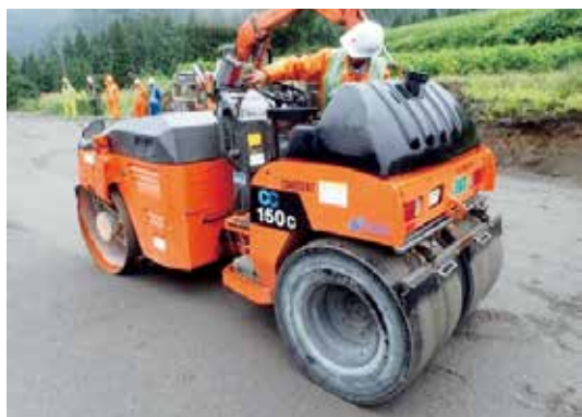
写真9 ICT建機による「締め固め」の状況
