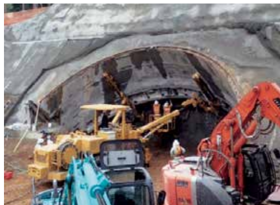
写真3 2ブームドリルジャンボによる支保架設
