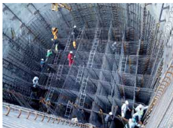
写真4 斜め坑内での鉄筋組み立て
