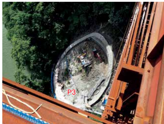
写真7 片掛橋P3橋脚の施工状況
