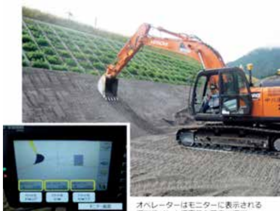
写真8 ICT建機による切土状況
