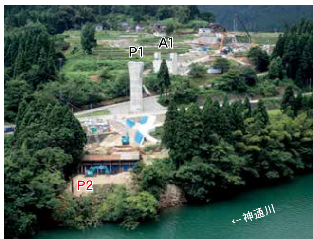
写真6 片掛橋P2橋脚の施工状況
