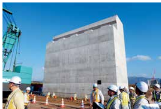
跨線橋AU1橋台縦壁前面
