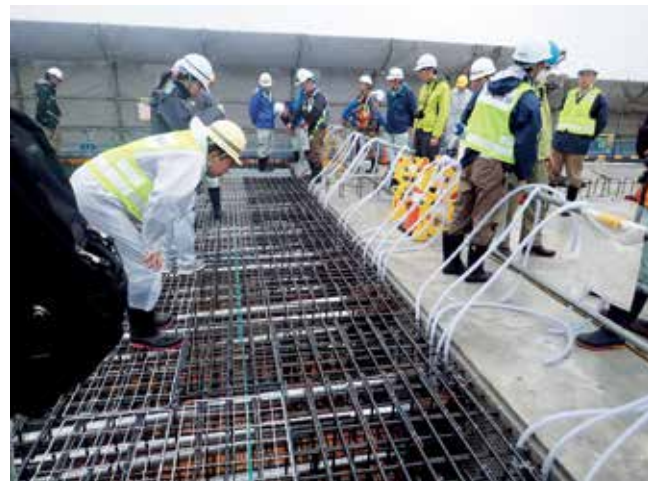
利田高架橋 配筋状況
