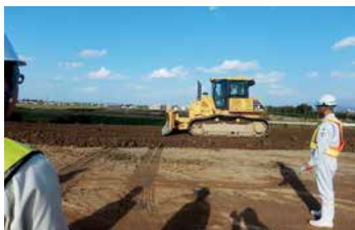
マシンコントロールブルドーザ
