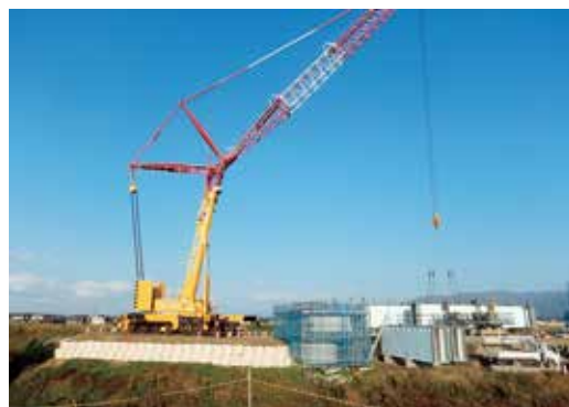
鋼箱桁取付施工風景
