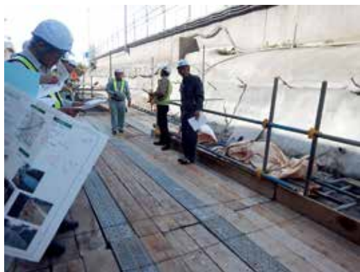
OFFランプ側地山補強壁面工
