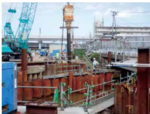
迂回路仮橋基礎工
