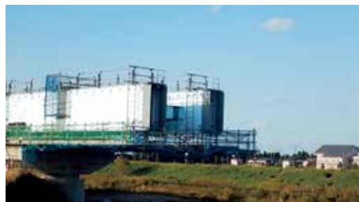
上部工 幅細鋼箱桁
