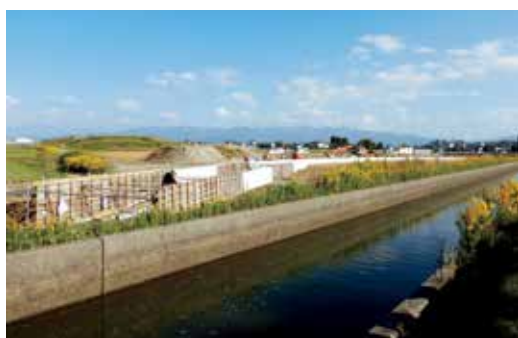
新江用水路仮廻し施工風景
