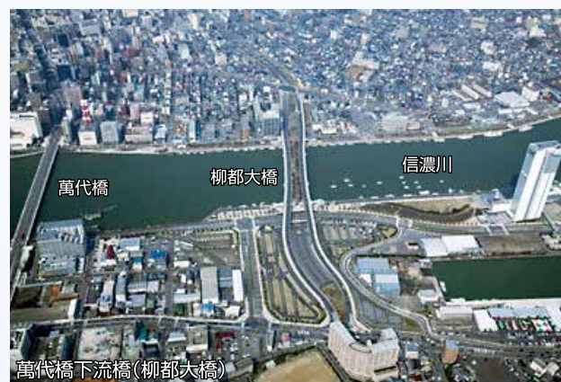
③万代島ルート線・萬代橋下流橋(新潟県) 写真提供:国土交通省 新潟国道事務所
