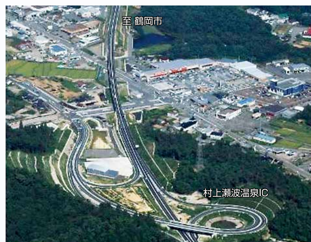
② 日本海東北自動車道(新潟県) 写真提供: 国土交通省 羽越河川国道事務所
