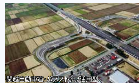
③ 長岡南越路スマートインターチェンジ(新潟県) 写真提供: 長岡市
