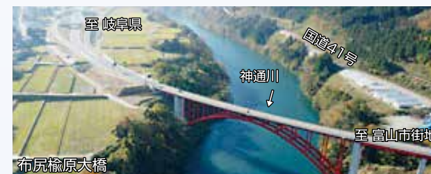
③ 富山高山連絡道路・猪谷楡原道路(富山県) 写真提供: 国土交通省 富山河川国道事務所
