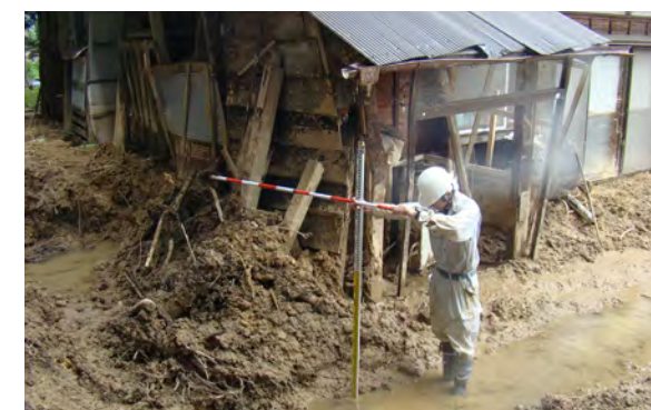
土砂災害調査 (平成23年：新潟県三条市)
