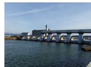
梯川逆水門 (石川県小松市)
