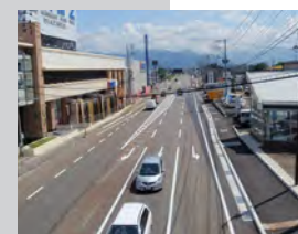
国道 17 号美佐島交差点対策後 左折レーン追加 (新潟県南魚沼市)
