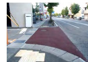
国道 157 号市道取付部カラー舗装 (石川県金沢市)
