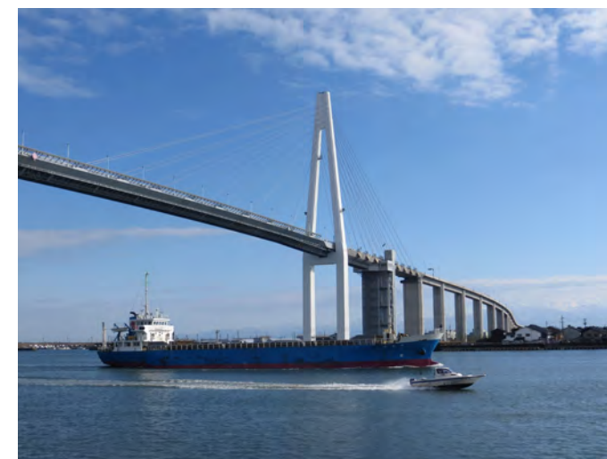
新湊大橋・富山新港 (富山県射水市)
