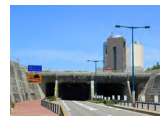
新潟みなとトンネル (新潟県新潟市)
