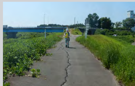
前川の点検 (石川県小松市)
