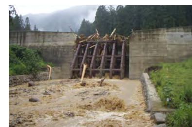
姥沢川第 2 号砂防堰堤 (新潟県南魚沼市)
