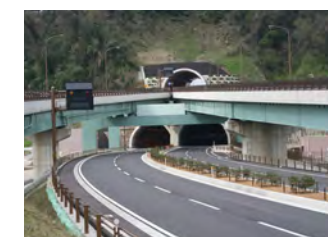
金沢外環状道路 崎浦涌波トンネル (石川県金沢市)
