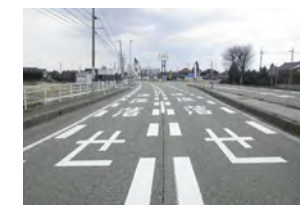
国道 156 号注意喚起舗装 (富山県高岡市)
