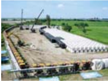
根固ブロック工約700個製作済(H24.9現在)
