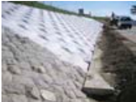
法覆護岸施工状況
