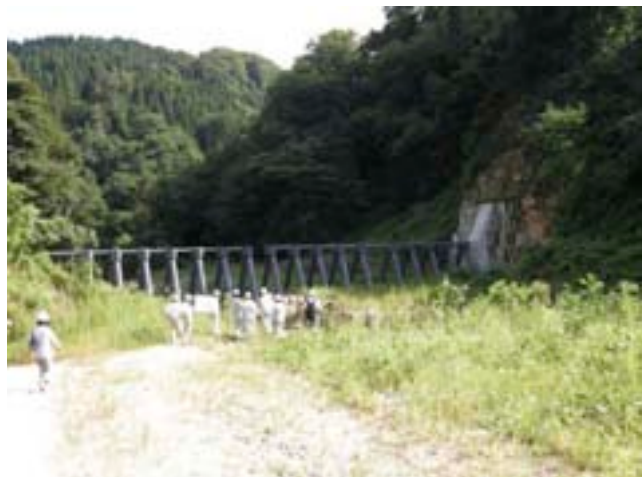
写真－2 流木止め
