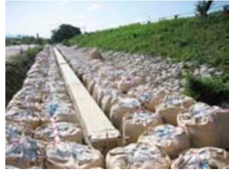
笠コンクリート施工状況 (H24.9現在)
