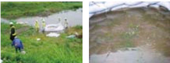
応急対策：釜段工
