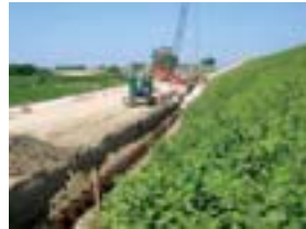
遮水矢板施工状況 (H24.9現在)
