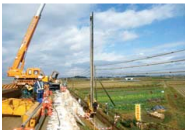
(鋼矢板工法：圧入工法)
