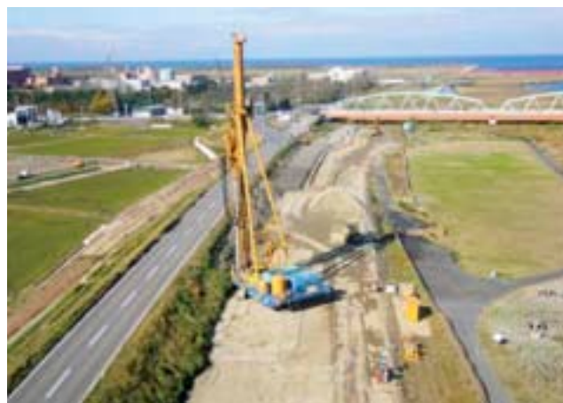
(締固め工法：サンドコンパクションパイル工法)
