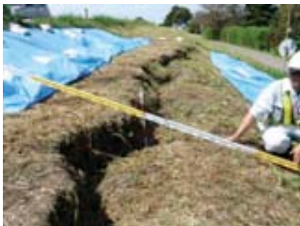
応急対策：シート張工
