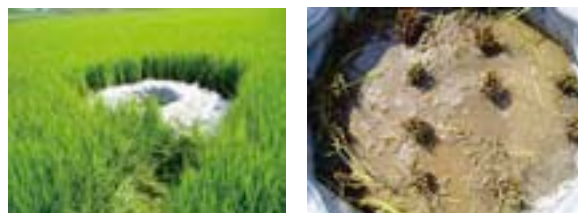
応急対策：釜段工
