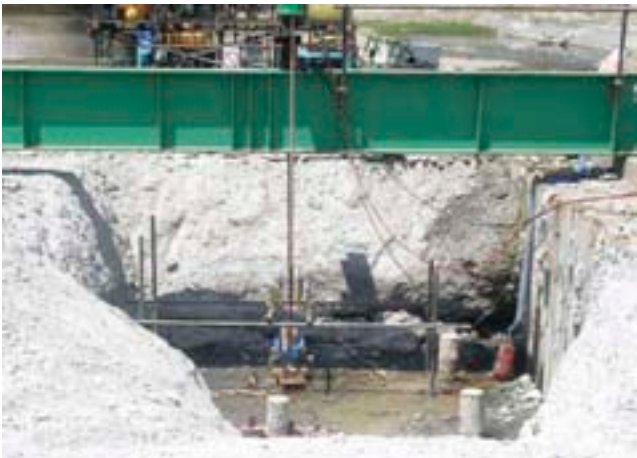
写真-2 松杭の杭頭部及び引抜き試験の様子
