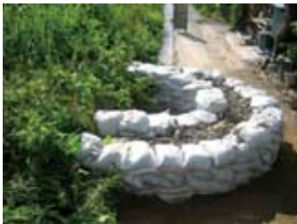
応急対策：月の輪工
