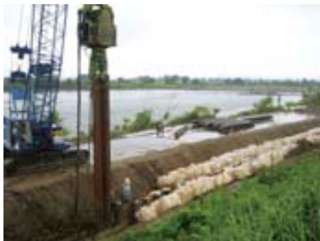
遮水矢板工施工状況
