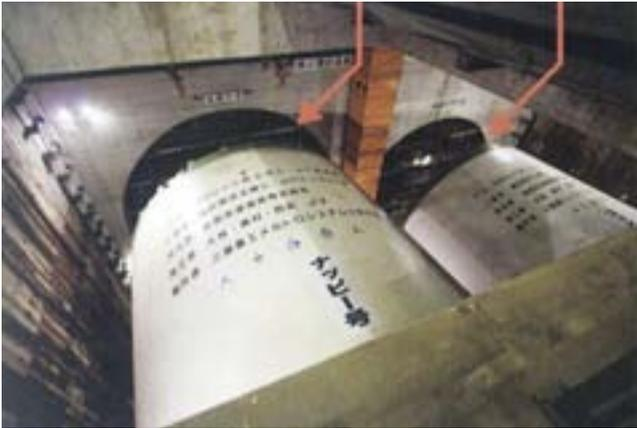
写真3. 掘削開始直前のシールドマシン
