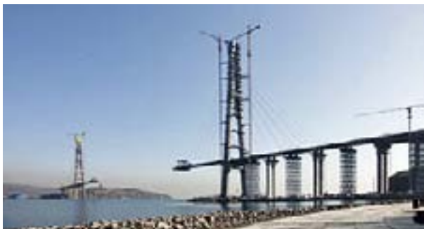
工事中の主塔
