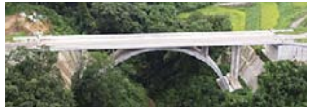
麻生第二高架橋の全景
