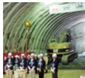
七尾トンネル 貫通式のようす
