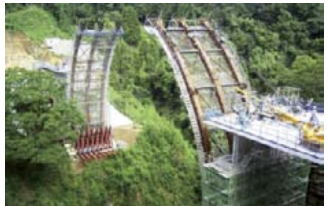
麻生第二高架橋 メラン材の架橋状況
