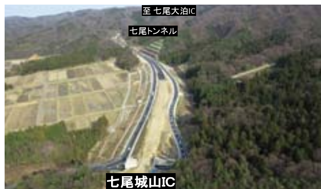
七尾城山ＩＣより七尾大泊ＩＣ方面を望む
