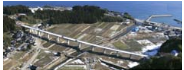
熊淵川橋の全景
