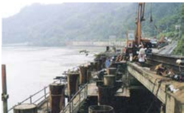
図ー4 阿賀野川側への道路補強工事
