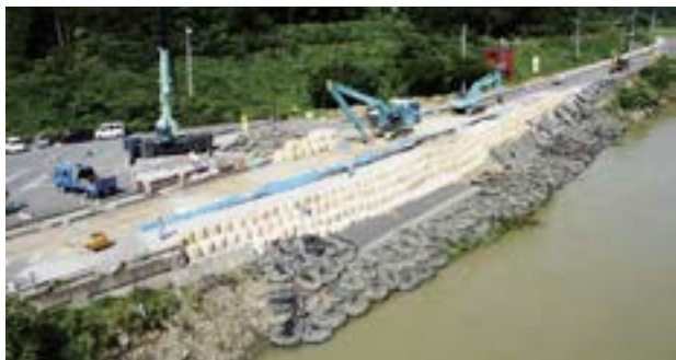
図-13 被害拡大防止工事完了（H25. 7.21 18時）
