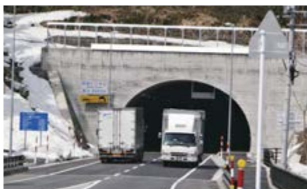
図－11 開通後のすれ違い状況（赤岩トンネル） （平成25年4月）
