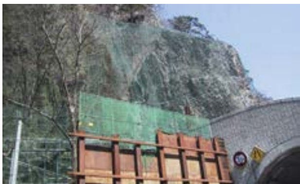
図ー3 落石防止のための法面对策
