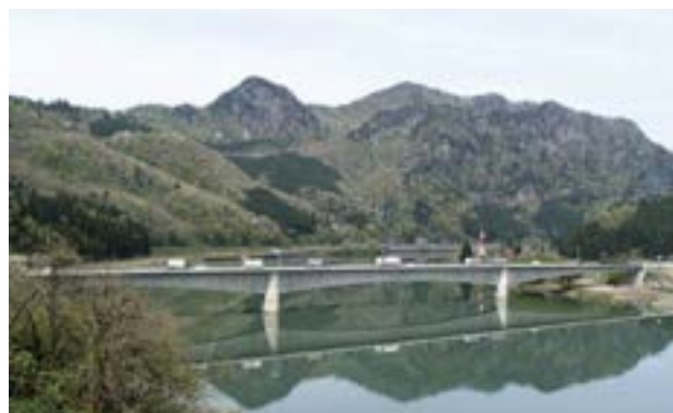
図ー7 開通後の状況（小花地大橋）（平成25年5月）
