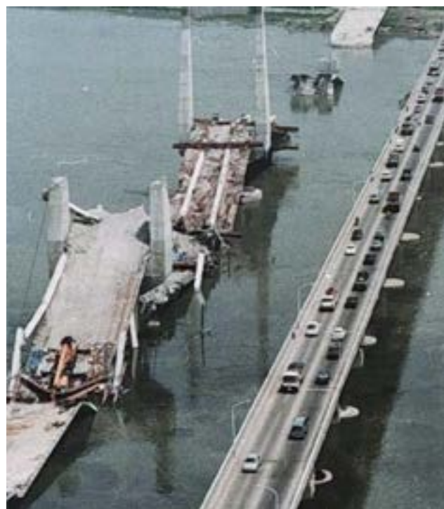
新幸州大橋の落橋の様子：右側の幸州大橋をバスで通過しながら衝撃的な光景は、忘れられない
