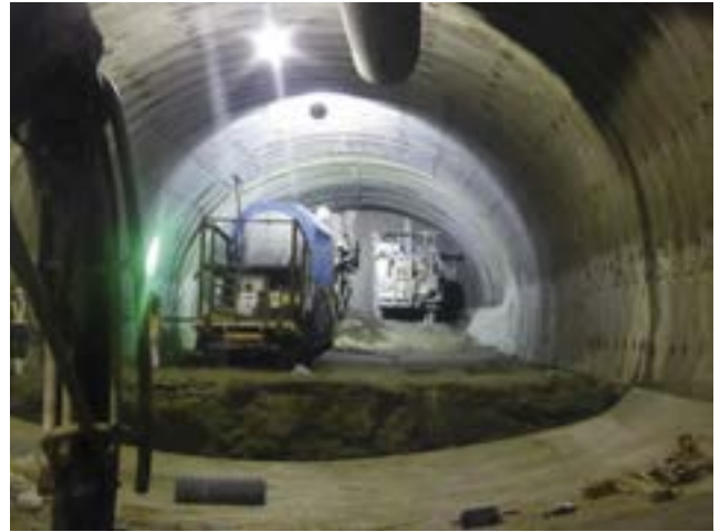
図10. 氷見第15トンネル 切羽先端状況
