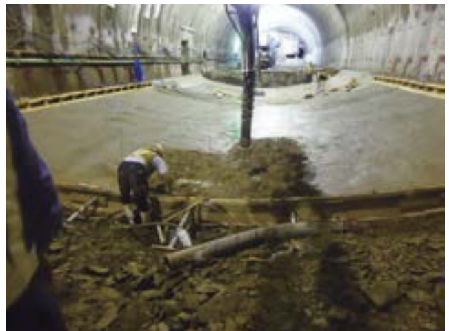
図11. 氷見第15トンネル インバートコンクリート施工
