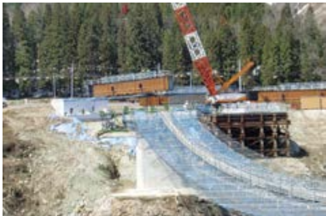
写真-7 上部工架設
