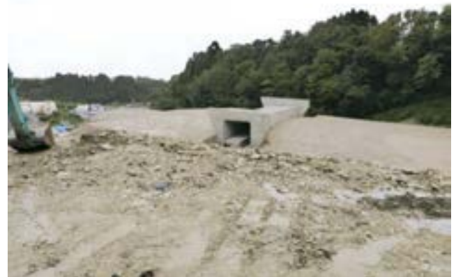
図3. 脇地区大規模土工現場
