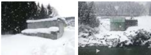
写真-5 A2橋台 (H25.1) 写真-6 P1橋脚 (H25.1)
