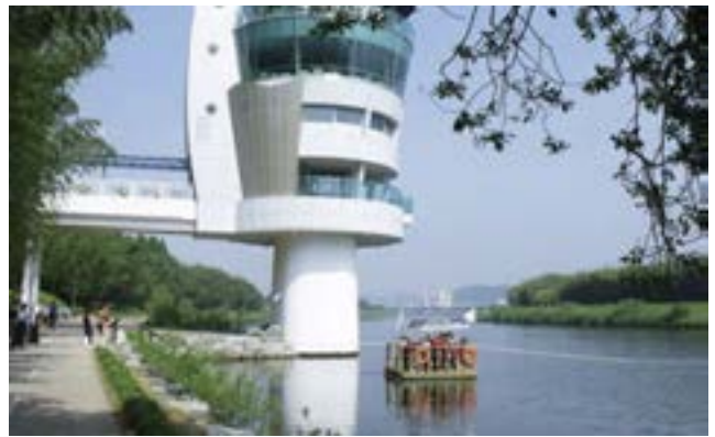
ゴミ一つない太和江をロープによる渡し船に乗船 (旧取水塔が展望施設に改変)
