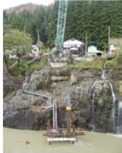
写真-3 基礎工（P1）
