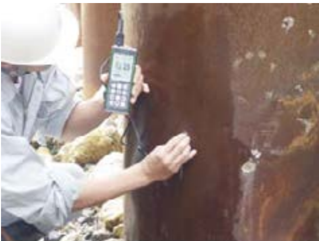
写真4. 鋼製部材磨耗調査
