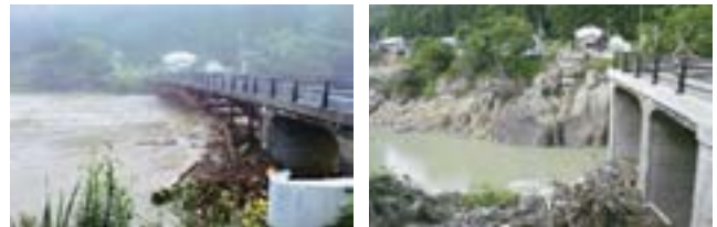
写真-1 被災直前 (H23.7.29金山町 HP より)
