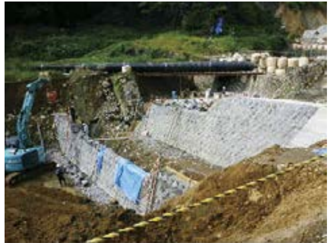
写真1. 既設床固工補修状況
