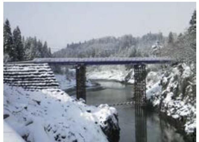
写真-4 施工完了後の二本木橋（仮橋）
