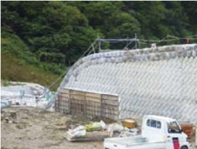
写真3. 水通し部石積み補修状況
