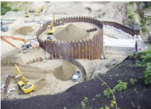
南平及び神沢川で採用した鋼製セル式砂防堰堤
