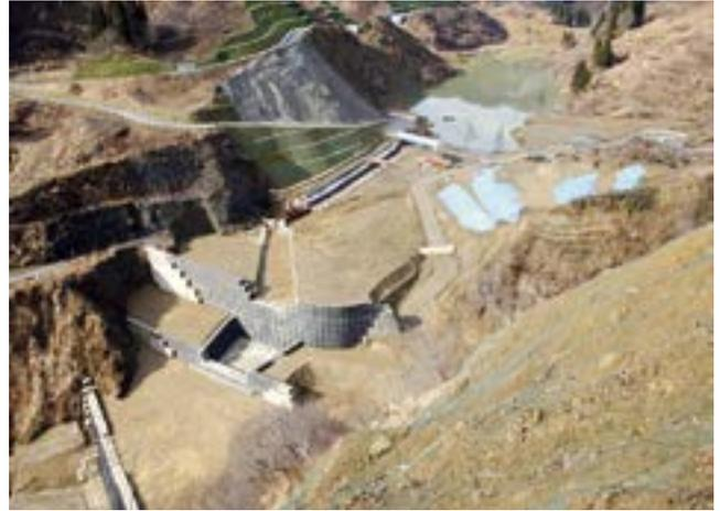
寺野河道閉塞対策（ISM工法により基礎部を施工）
