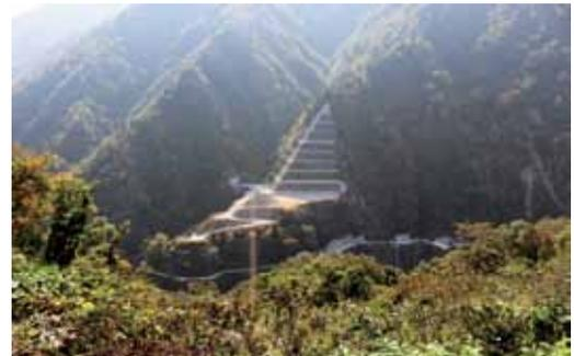
写真1 ダムサイト展望台から望むダム左岸袖部の大切土
