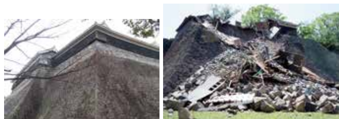
【国指定の重要文化財】東十八間櫓（左 震災前、右 震災後）
