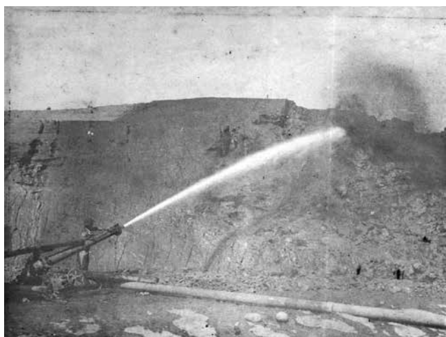
ジャイアントポンプによる射水作業
