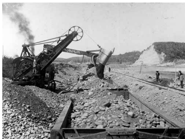
土砂積み込み作業
