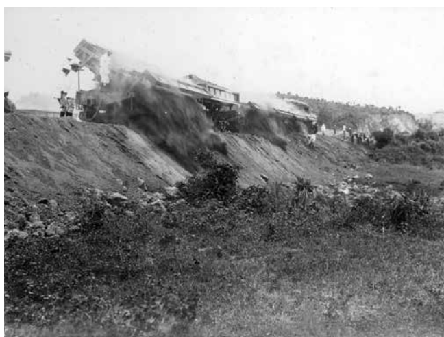
堰堤の土砂積み上げ
