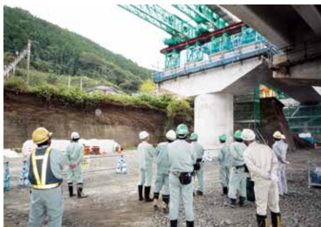
架設桁架設(3工区)の見学状況
