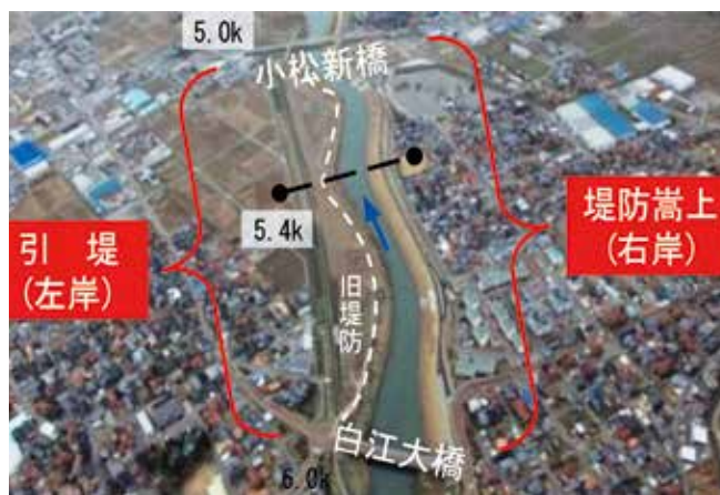
写真3 小松新橋～白江大橋の堤防整備（H24）
