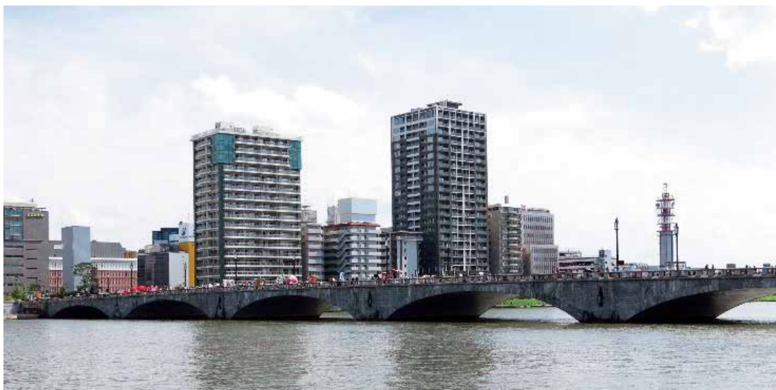
写真11 現在の万代橋
