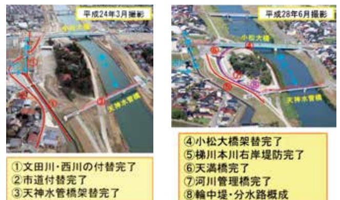
写真6 分水路関連工事の実施状況
