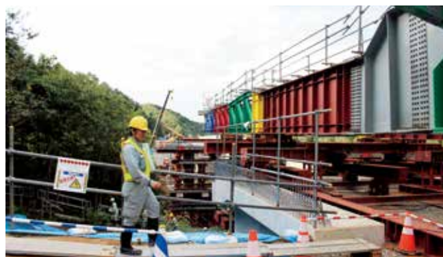
滝寺第一橋 (送り出し架設)
