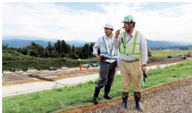
五日市工事現場
