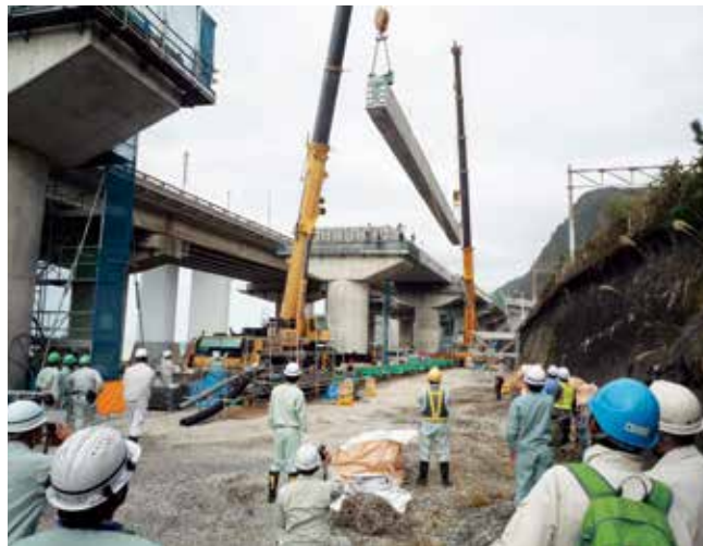
クレーン架設(第2工区)の見学状況
