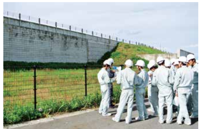
擁壁・軽量盛土見学（右岸）
