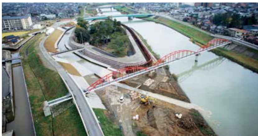
写真9 ドローンによる通水の映像
