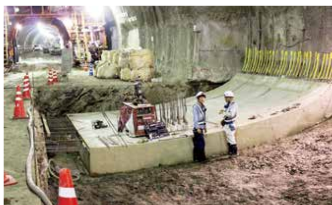
宮内トンネル坑内 (インバート工事)
