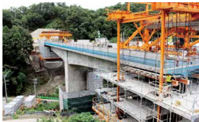
雪森橋張出し架設 (移動作業車解体中)
