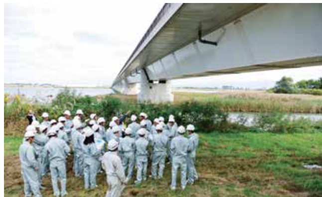
橋梁見学（左岸側高水敷）
