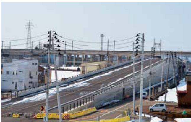
東から跨線橋を望む
