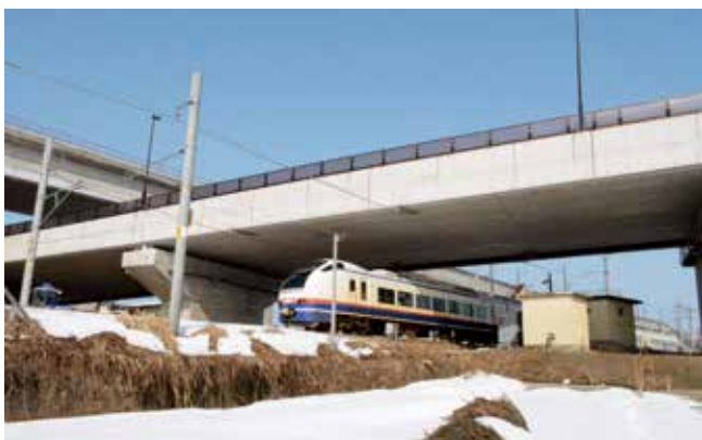
信越本線と立体交差の様子
