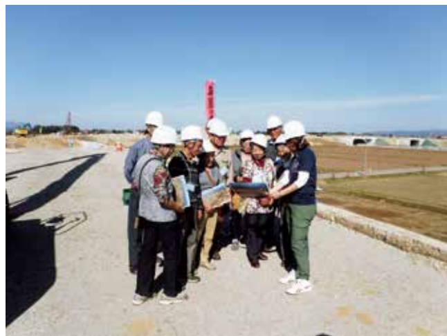
長岡北スマートIC建設現場にて説明する筆者T (H28.10)
