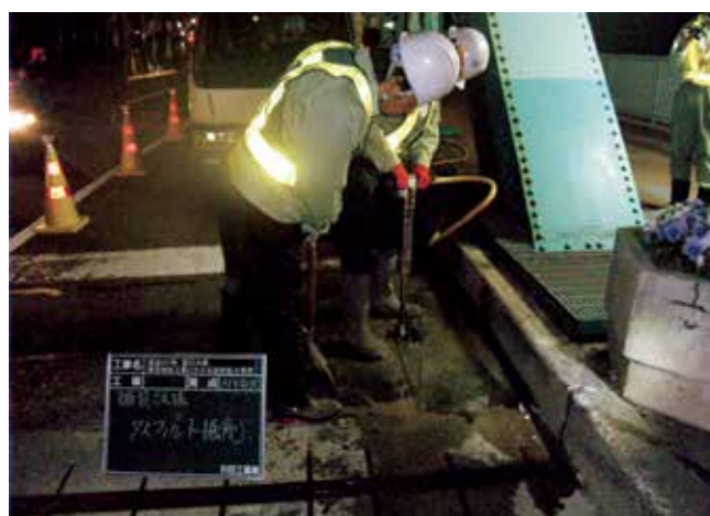
道路試掘による舗装・床版調査
