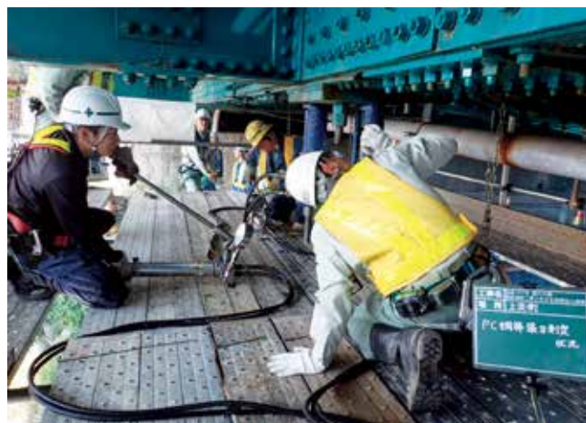
足場設置による垂直材の張力測定
