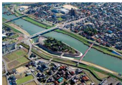
写真4 小松天満宮改修（分水路方式）H29.11完成
