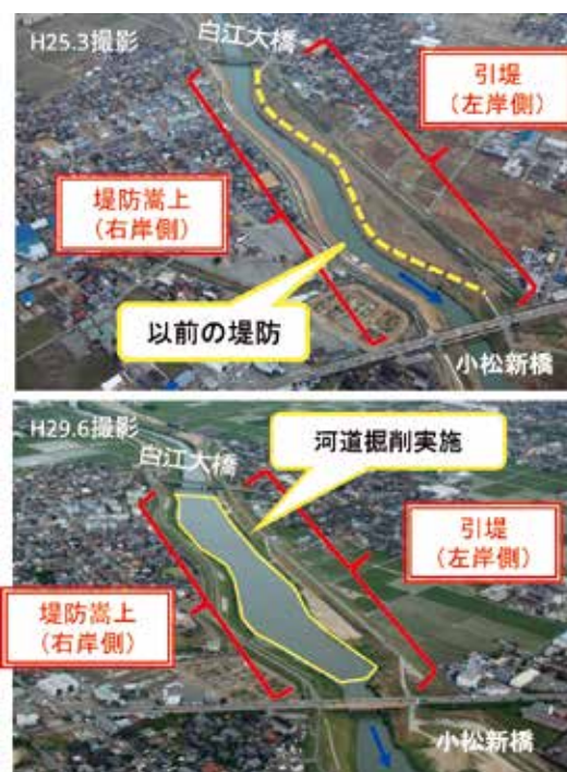
写真3 小松新橋から白江大橋間の引堤等実施状況
