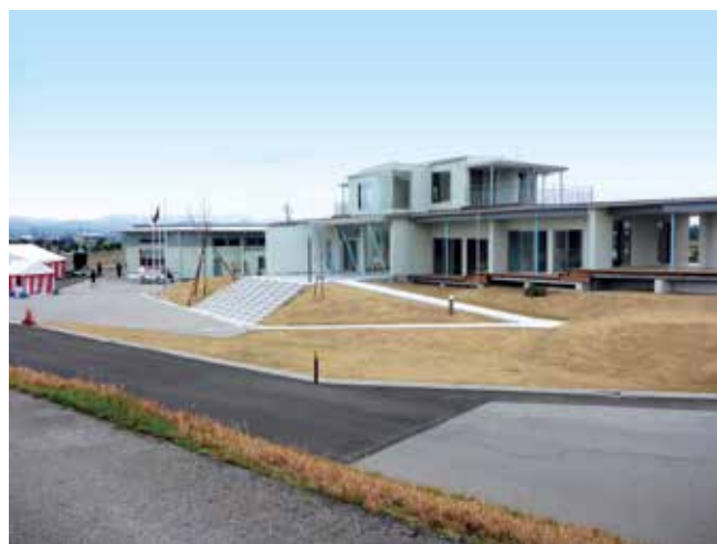
写真6 小松市の梯川ボートハウス
