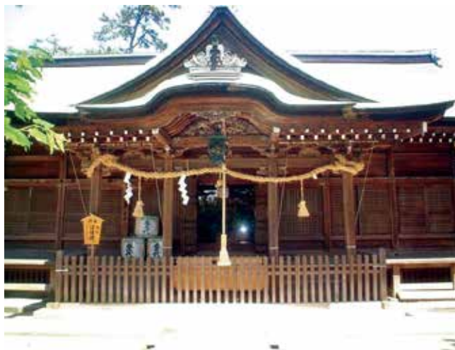
写真2 国指定重要文化財 小松天満宮本殿
