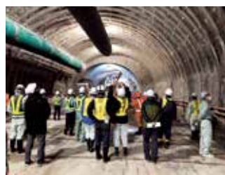
トンネル坑内の切羽見学
