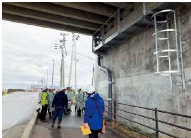
百津跨道橋の見学(橋台周辺)
