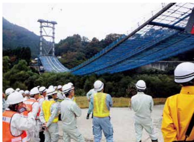
ワイヤーブリッジ、鉄塔設置状況
