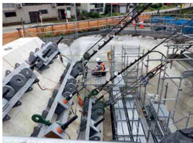
アンカーフレーム設置状況
