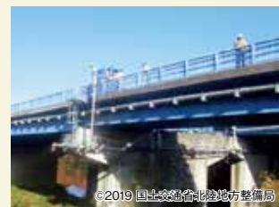
橋梁点検作業 写真提供:北陸地方整備局
