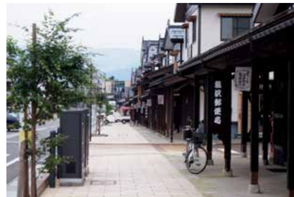
三国街道塩沢宿「牧之通り」電線共同溝（新潟県南魚沼市）
