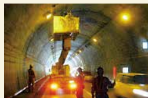
目視・打音検査
