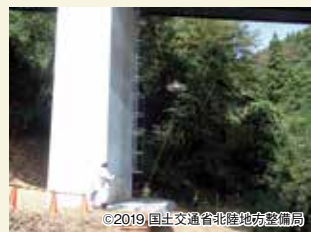
ドローンを活用した点検 写真提供:北陸地方整備局
