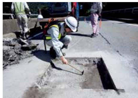
橋梁補修設計の詳細調査
