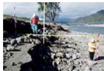
被災箇所調査状況
