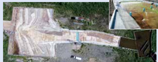
大河津分水路模型実験(北陸地方整備局)
