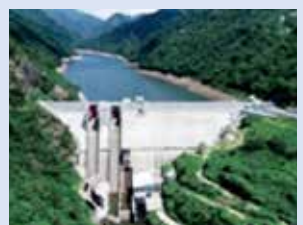
笠堀ダム(新潟県三条市) 写真提供:新潟県
