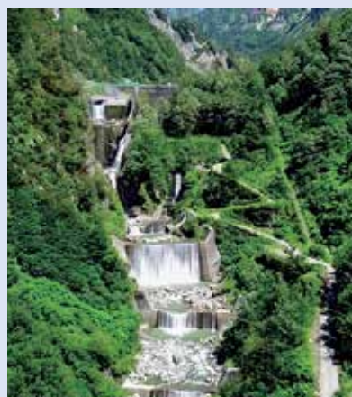
重要文化財 白岩砂防堰堤 一級河川常願寺川水系湯川(富山県富山市／立山町)
