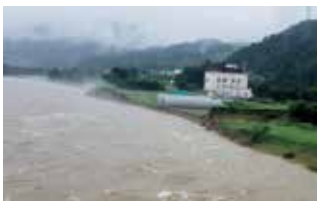
被災状況 写真提供:国土交通省 富山河川国道事務所
