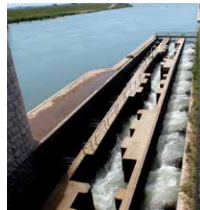
大河津分水洗堰の魚道（新潟県長岡市／燕市）
