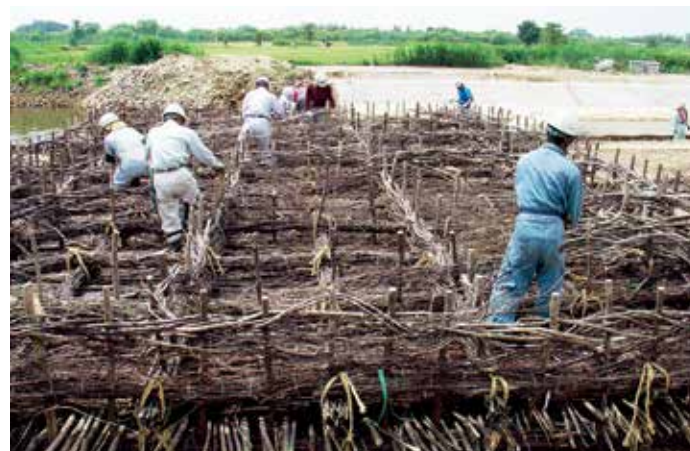
信濃川の粗朶沈床工法（新潟県新潟市）
