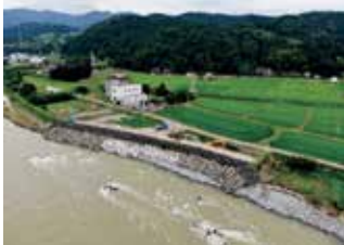
応急復旧状況
