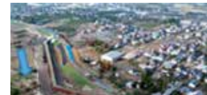
鋼矢板仮締切堤防・仮堤防完成状況 (R1.10.30) 写真提供:国土交通省 千曲川河川事務所
