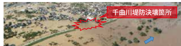
千曲川堤防決壊箇所 被災状況(10月13日 PM1:10頃撮影)
