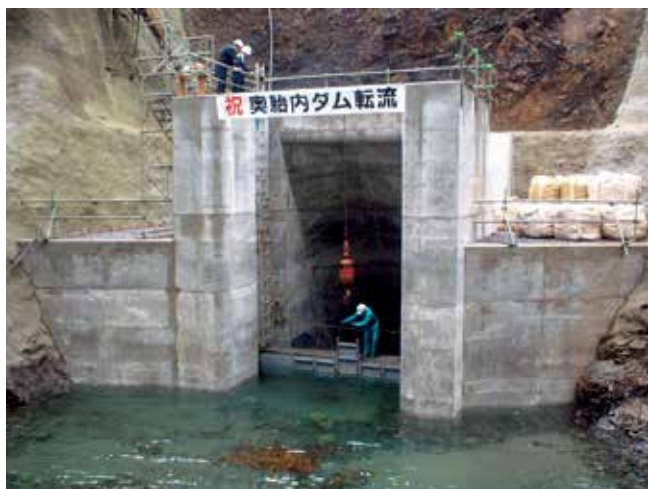
仮排水トンネル呑口部
