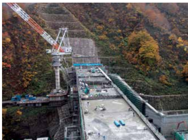
堤体コンクリート打設
