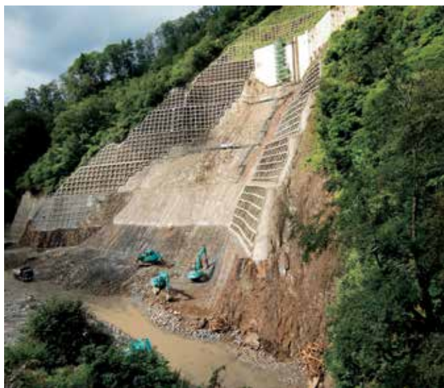
右岸堤敷掘削状況
