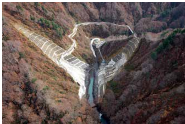
本体掘削完了(下流上空より)
