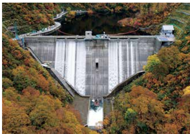
サーチャージ水位到達時
