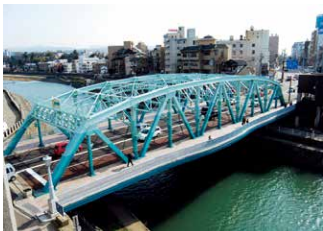
写真1 国道157号犀川大橋
