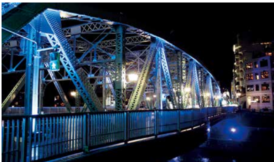
写真10 青色にライトアップされた犀川大橋（左岸側）
