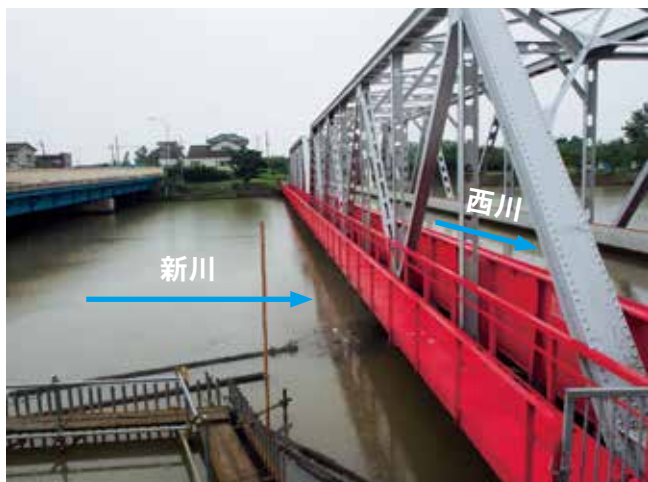
写真1 西川水路橋（撮影：田邊）
