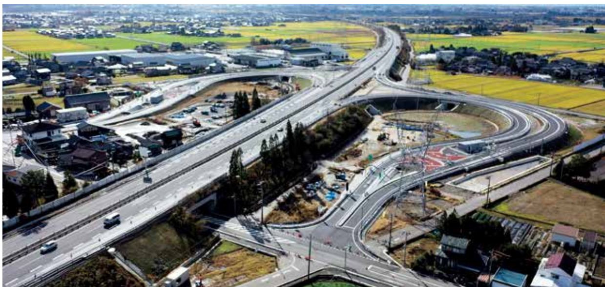
上市スマートインターチェンジの整備状況
