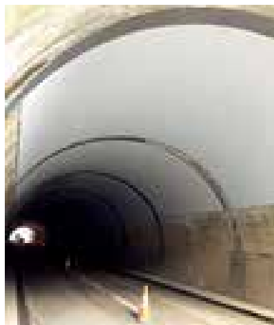
写真1 HTパネル施工例
