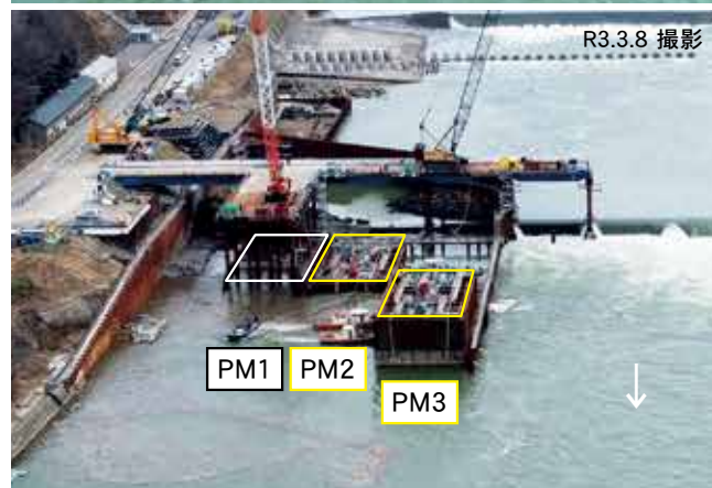
図9 鋼殻ケーソン据付・設置の状況
