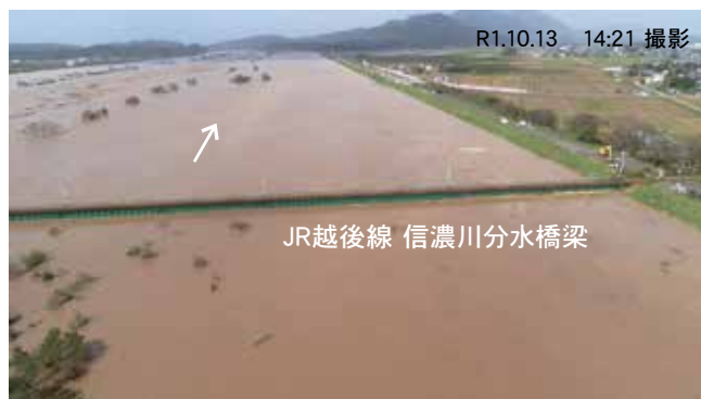
図2 令和元年東日本台風による洪水の状況 （JR越後線 信濃川分水橋梁）
