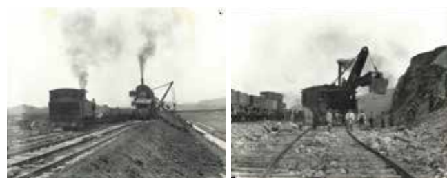
図4 大河津分水路の開削で使用された大型土木機械
