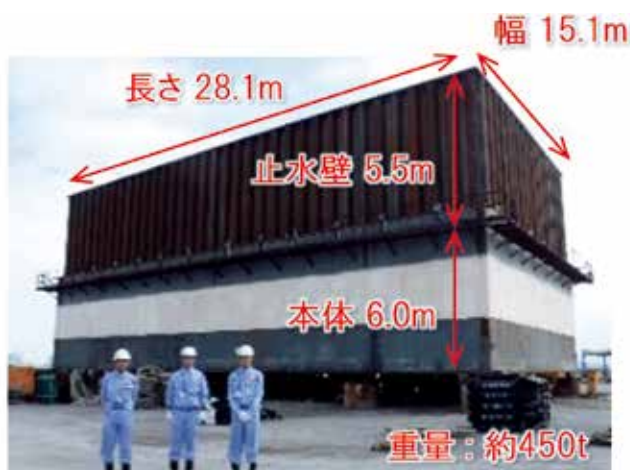
図8 新第二床固 鋼殻ケーソン
