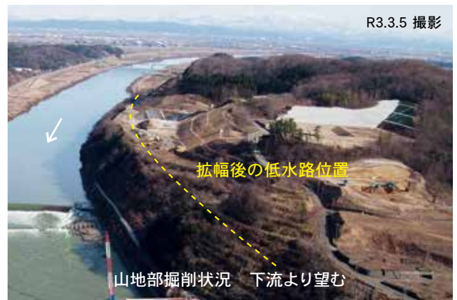
図6 山地部掘削の状況
