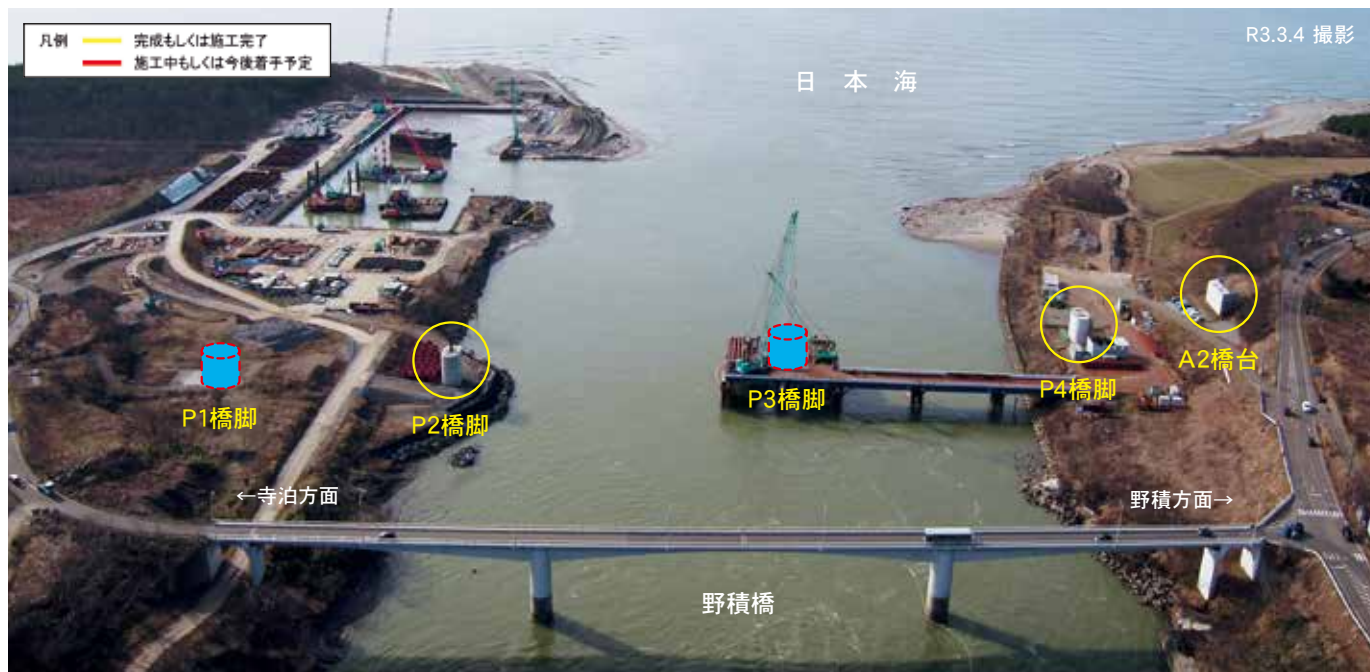
図10 野積橋架替工事全景
