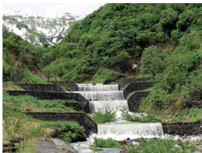
万内川階段式砂防堰堤群（現在）
