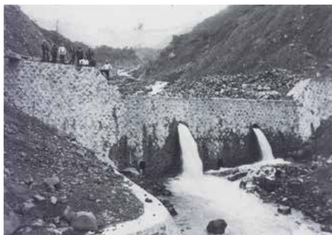
万内川一号砂防堰堤（竣工当時）
