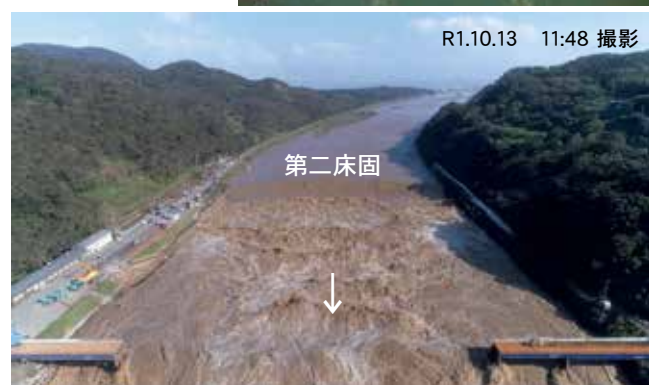
写真2 令和元年東日本台風による洪水の状況（大河津分水河口部）
