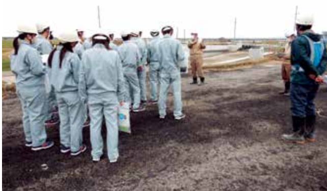
PC橋上部工事の見学
