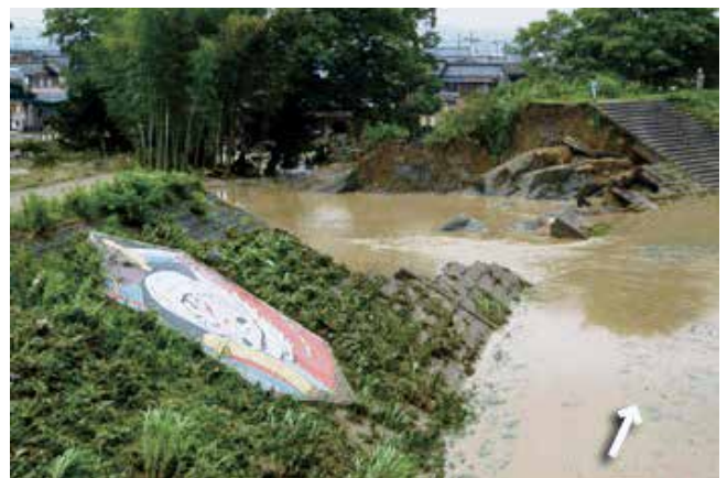
写真2 7.13水害 刈谷田川堤防決壊箇所 (出典：北陸地方整備局「水害レポート2014」)
