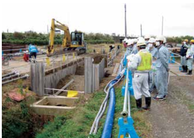
水路ボックス工事の見学
