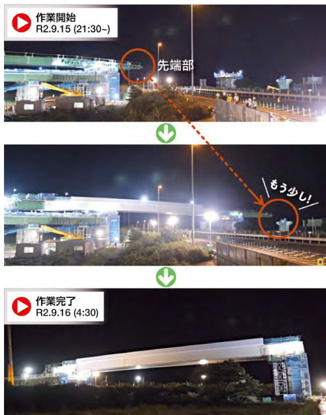
写真-4 橋げた架設の様子
