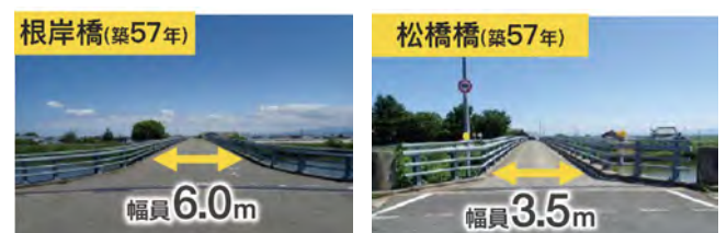
写真-2 中ノ口川大橋と既設橋梁
