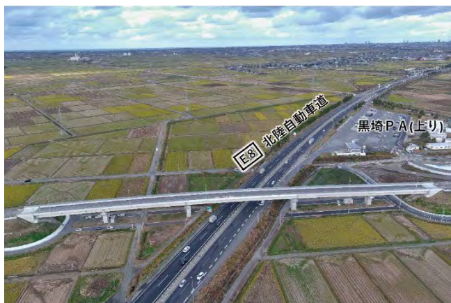
写真-3 くろさき茶豆大橋
