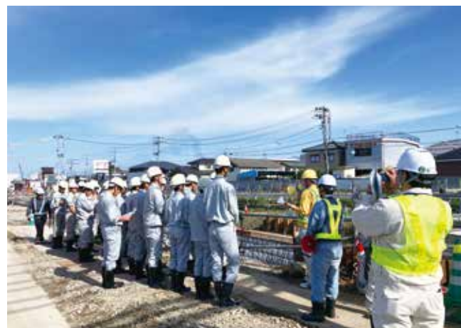
写真3 栗ノ木川付替工事の見学
