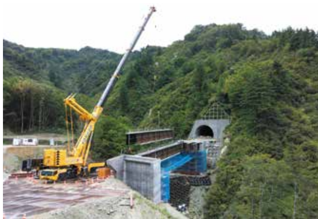
写真-3 B橋梁上部工施工状況
