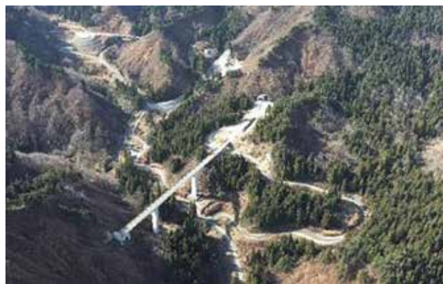
写真-1 八十里越本線と工事用道路
