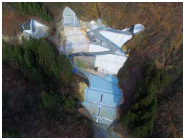
写真-4 盛土施工状況
