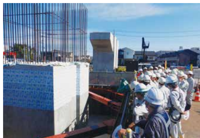
写真4 栗ノ木高架橋・橋脚工事の見学
