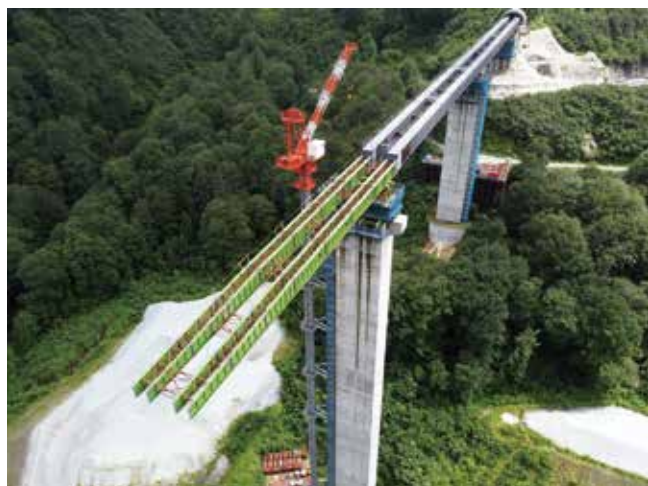
写真-6 5号橋梁上部工施工状況
