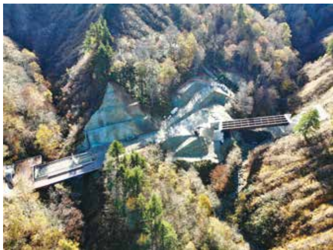
写真-2 A橋梁～B橋梁区間全景
