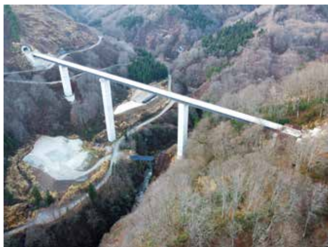
写真-5 5号橋梁全景
