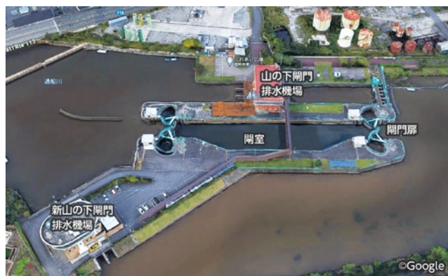
写真1 山の下閘門排水機場
