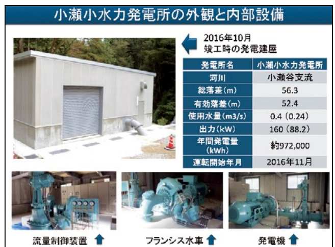
小瀬小水力発電所の様子
