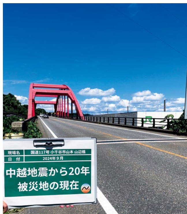
写真4 小千谷市山本 山辺橋
