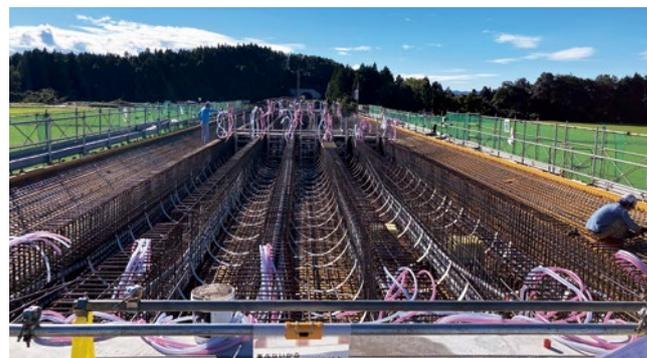
写真3 床版配筋、シース設置状況
