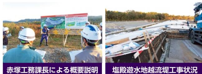
遊水地とは洪水時に信濃川のピーク流量の一部を一時的に貯留する施設で、下流側の河川水位を低下させる機能があります。塩殿遊水地は、河道と調節池を仕切る囲繞堤、遊水池と堤内地を仕切る仕切堤、河道内の洪水を調節池に導水するための越流堤からなり、このうち、現在工事中の越流堤の構造について説明して頂きました。越流堤は、洪水時に堤防の上を流水が勢いよく流れるため、堤防天端、川裏、川表の法面の3面は全てコンクリートで被覆され、また堤防内には堤防内の水や空気を排出するための排気管や水抜き孔、点検孔等が設置されており、堤防の安全性を確保するための様々な工夫について学ばせていただきました。
