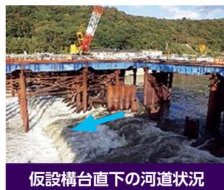
工事業者様からは、基本流量を通水させながらの難しい工事であることや、仮締切方法の工夫や工事手順の変更等、現場での臨機応変な対応が必要な中、着々と工事が進んでいる状況をご説明いただきました。平常時でも水量の多い河道内での工事、潜水士の呼吸音、大河津分水路を横断する長尺な仮棧橋等、厳しい条件下での工事には、そのスケールや規模に只々、圧倒されるばかりでした。
