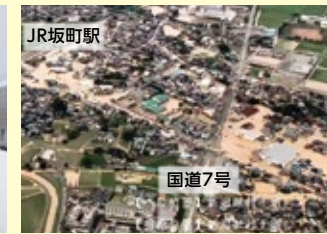
(R4.8 大雨の被災状況 [新潟県])
