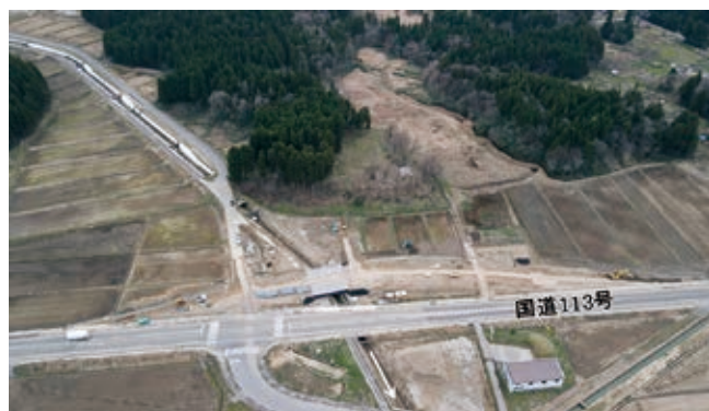
写真-4 橋梁架替〔助成事業区間〕
