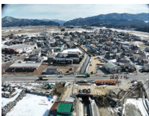
写真-5 河道拡幅・橋梁架替〔復緊事業区間〕
