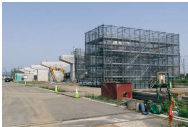
写真-4 県道の橋脚（富山県高岡市）
