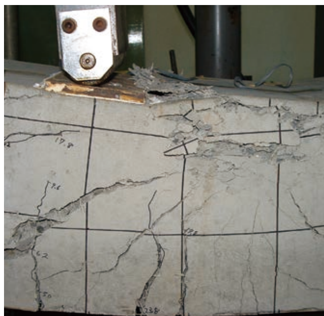
写真-2 写真の一例 (はりの圧縮破壊)
