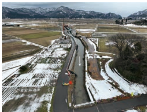
写真-3 河道拡幅〔助成事業区間〕
