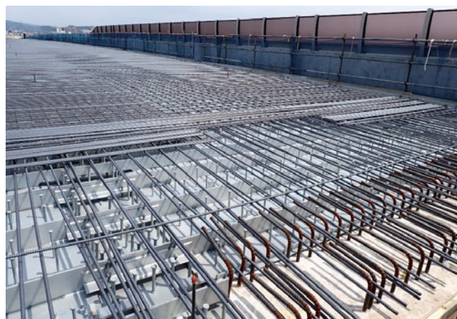
写真2 P3-A2径間の床版鉄筋工の状況
