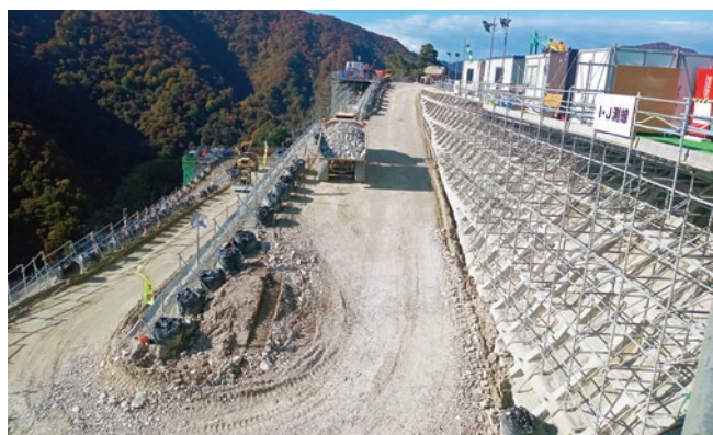
重ダンプトラックによる土砂運搬
