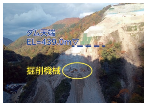
ダム右岸側の掘削状況
