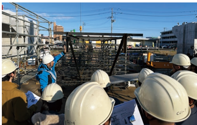
写真6 地上で組み立てたプレハブ鉄筋の見学
